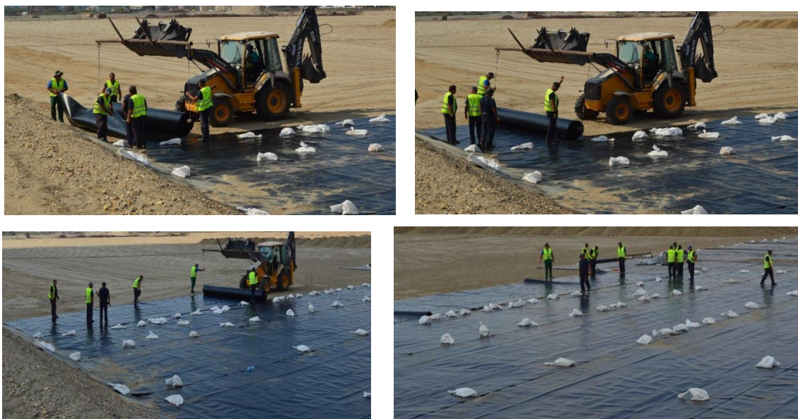
Slika 5.5.1. Postavljanje HDPE folije
