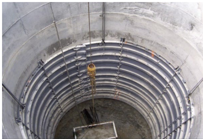
Slika 4.4.7. Deonica okna podgrađena monolitnim betonom
