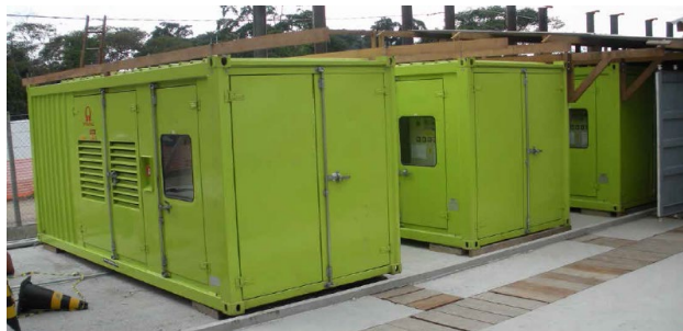
Slika 7.2.5b. Generator set montiran u kontejner
